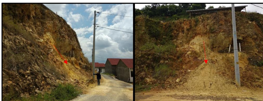
Gambar 5. Kondisi Lereng Setelah terjadi Gerakan Massa (Tampak samping dan Tampak Depan)
